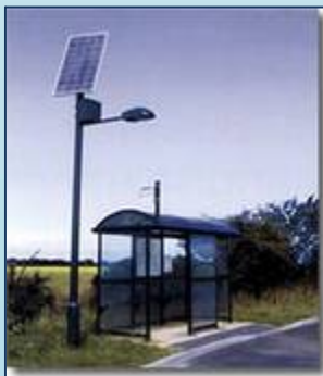
Eclairage public autonome
